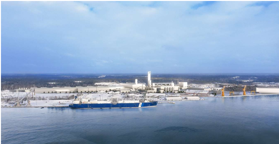
Kuva 29. Havainnekuva suunnitellusta vihreän teräksen tehtaasta ja sitä ympäröivästä alueesta. Tehdasalueen keskellä näkyy noin 140 metriä korkea suorapelkistysuuni, jossa rautamalmipelletit pelkistetään vedyn avulla rautasieneksi.
