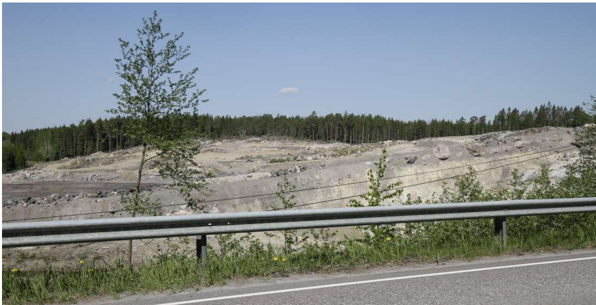
Kuva 14. 2020-luvulla avattu kiviainesten ottoalue Satamatien länsipuolella. Kuva: FCG, Minttu Kervinen, 24.5.2023.
