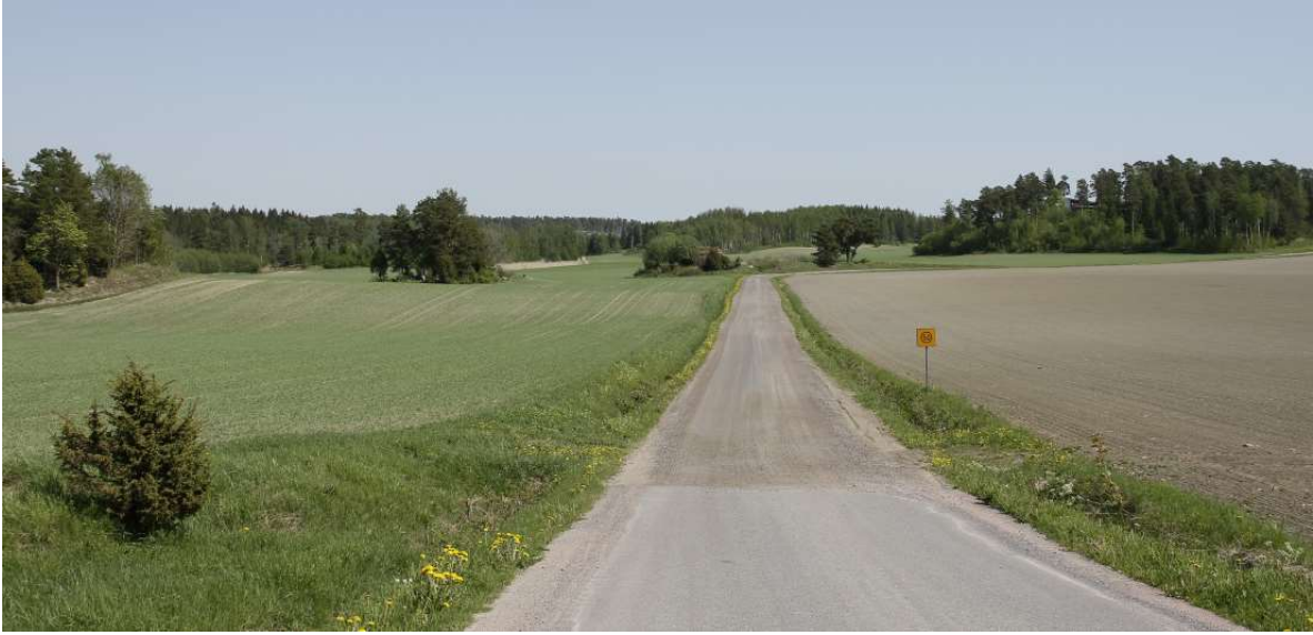
Kuva 10. Näkymä itään kohti Joddböleä Barösundintien ja Storramsjöntien risteyksestä. Maakunnallisesti arvokas kulttuuriympäristö Snappertunan-Fagervikin kulttuurimaisema jatkuu risteyksestä kaava-alueen länsi reunalle asti. Ennen kivihiilivoimalan purkamista paikalta näkyi sekä voimalaitoksen piiput että kattilahuoneet. Kattilahuoneiden korkeus on ollut 65 m mpy. Kuva: FCG, Minttu Kervinen, 24.5.2023.
