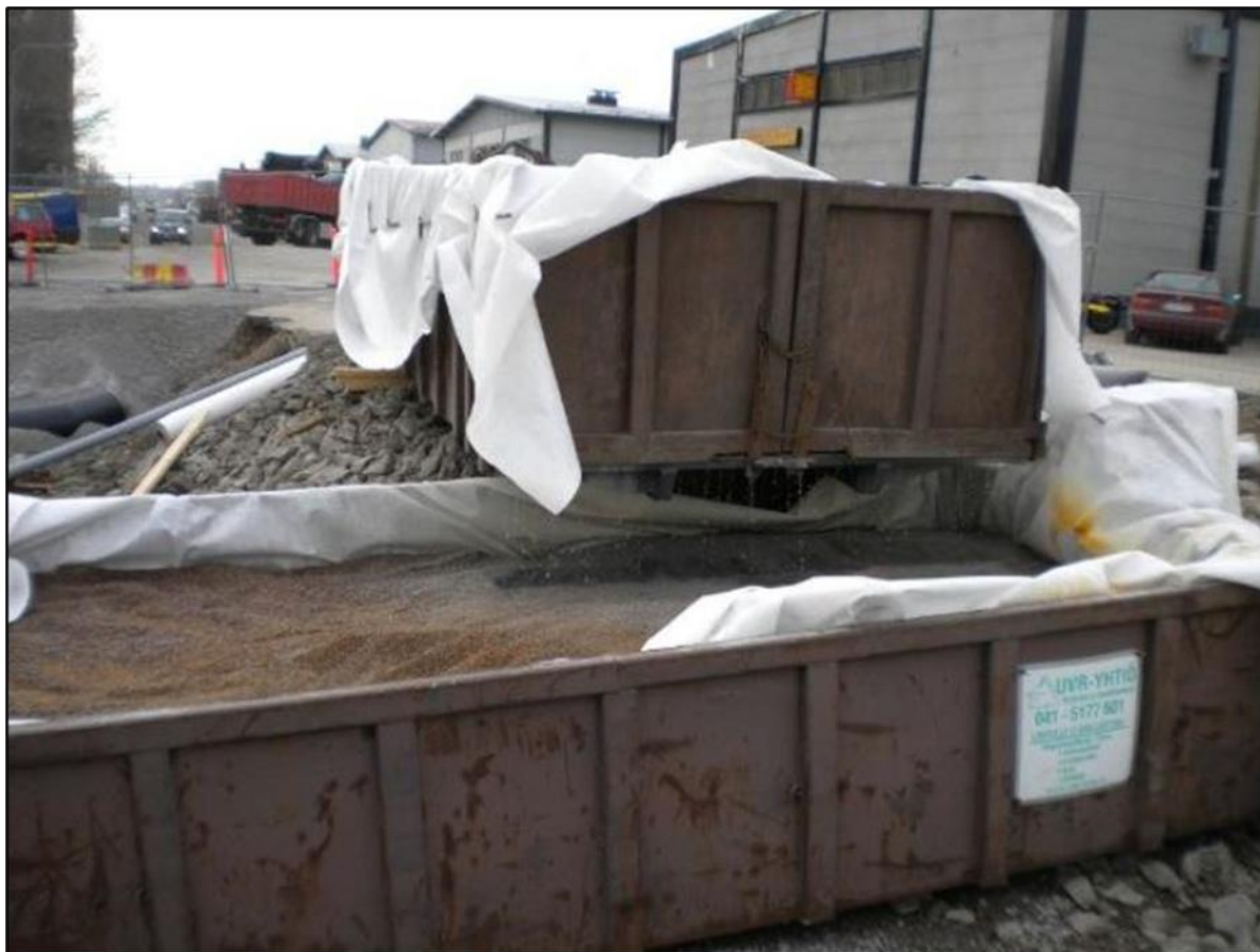
Bild 14 Exempel bild på ett filter gjort med en utbytbar container. 5
