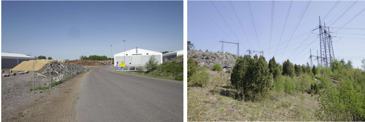
Bild 15 och Bild 16. Till vänster lagerbyggnaderna norr om Kraftverksvägen. I omgivningen runt dem lagras stockar under bar himmel. Till höger kraftledningarna på kullen norr om elstationen. Kullens krön ligger 41 meter ovanför havsytan. Foto: FCG, Minttu Kervinen, 24.5.2023.
