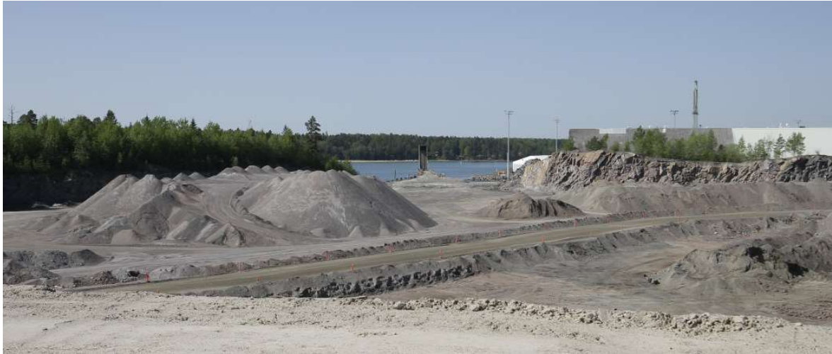
Bild 8. Utsikt från Fiskehamnsvägen 40 mot sydväst. I förgrunden ser man lagerfältet för stenmaterial. I bildens vänstra kant syns den skogbevuxna vällen mot stranden. I den högra kanten ser man hamnens kaolinlager. LNG-terminalfartyget blir bakom kaolinlagret. Foto: FCG, Minttu Kervinen, 24.5.2023.
