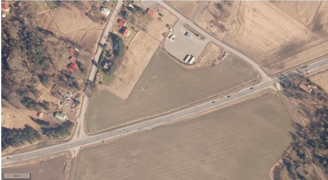
Kuva 39 Ilmakuva kantatien 51 sekä Degerbyn alueen liittymien ympäristöstä (Paikkatietoikkuna, Maanmittauslaitos).
